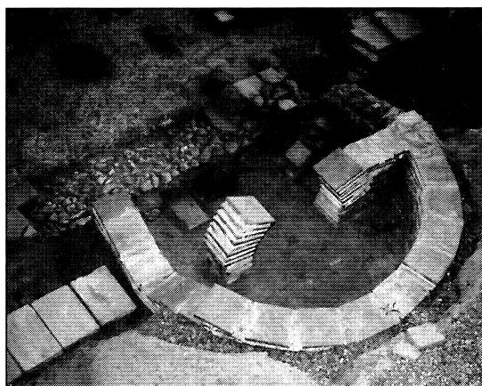
Fig. 9. Detalle del hypocaustum , parcialmente reconstruido, del alveus del caldarium (foto, V. García-Entero).
