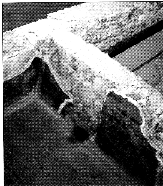
Fig. 11. Detalle del desagüe de la piscina occidental del frigidarium que comunica con la latrina (foto, V. García-Entero).
