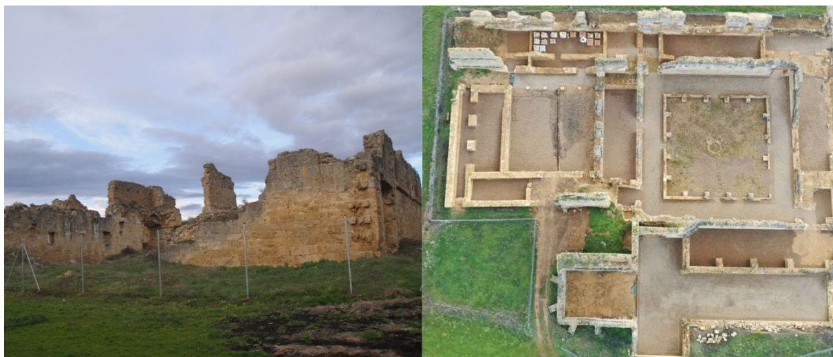
Figura 4. A la izquierda, estado del Monasterio de San Pedro de Eslonza previo a la rehabilitación (autora, 2014); a la derecha, vista aérea de los trabajos realizados en seis fases entre 2015 y 2021 (Rodríguez Sabadell y Valbuena Rodríguez, 2023).
