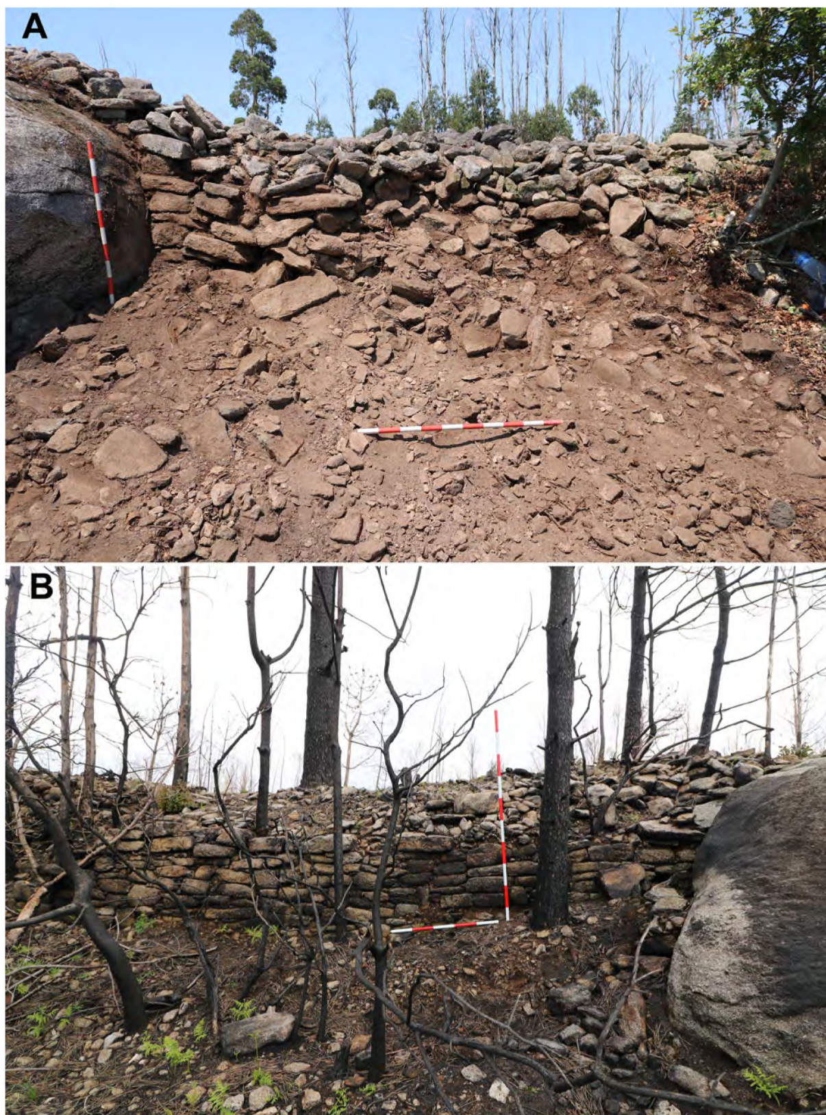
Figura 6. Vista de la cara exterior de la muralla, en el sector sureste. Las dos imágenes están separadas por el mismo afloramiento granítico (UE 2404). 6A: Imagen del sector excavado en el sondeo S2200. 6B: Vista del tramo mejor conservado de la muralla, durante la prospección de 2018 (fotografías de los autores).
