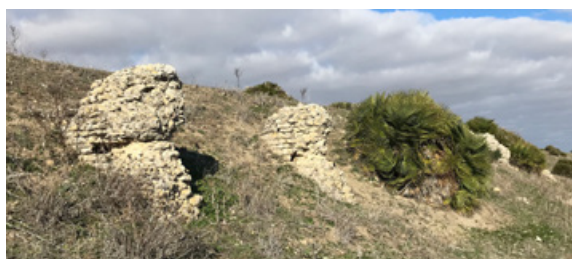
Figura 14. Detalle de algunos de los pilares de contención de la probable terraza forense, ya vistos en las figuras anteriores; se aprecia la vegetación invasiva que afecta a su conservación (fotografía propia).
