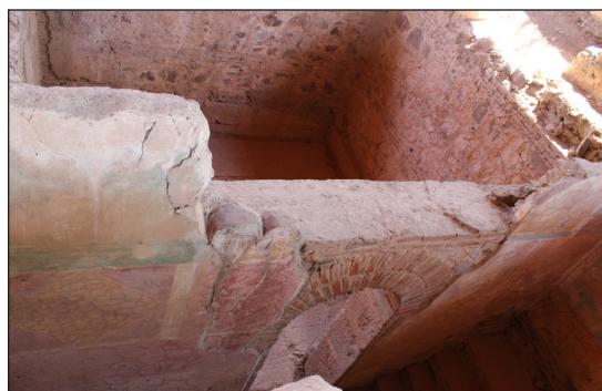
Figura 8. Detalle de la escalera de acceso al pasillo y a la antecámara del conjunto subterráneo de la Casa del Mitreo (Mérida). Se ve la decoración de las paredes con pinturas de imitación de crustae (Fotografía: G. Rodríguez Martín).
