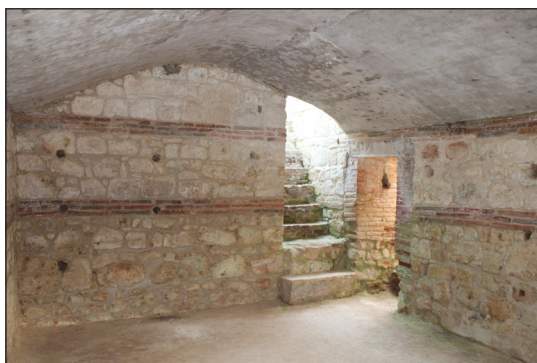
Figura 13. Vista del acceso a la habitación estival de la villa romana de Torre Águila. Se aprecia cómo la primera escalera descendía rectilínea y con gran pendiente hasta la sala (Fotografía: G. Rodríguez Martín).
