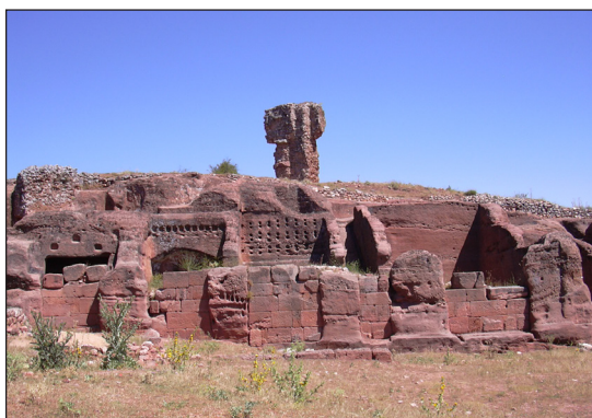
Figura 18. Particular de la Casa del Acueducto de Tiermes en donde vemos como se conjuga el hábitat rupestre y la construcción en opus quadratum . Obsérvense las huellas de las vigas de madera que sustentaban el forjado, también de madera del piso inmediatamente superior.
