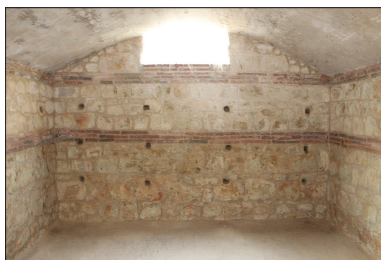
Figura 11. Interior de la estancia subterránea de Torre Águila (Montijo, Badajoz) que conserva la cubierta de bóveda rebajada en perfecto estado (Fotografía: G. Rodríguez Martín).
