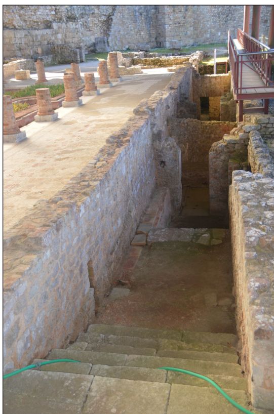
Figura 14. Escalera de acceso a la planta subterránea de la conocida como Casa dos Repuxos ( Conimbriga , Codeixa-a-Velha, Portugal). La luz que iluminaba dicha escalera se conseguía mediante lucernarios practicados en el muro de cierre del pórtico del peristilo (Fotografía: G. Rodríguez Martín).
