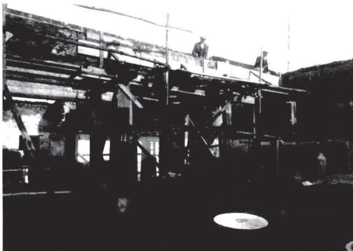
Fig. 4. Peristilo de la Casa/Caupona (1.8.8.9) durante la restauración (Fotografía de la «Soprintendenza Archeologica» de Pompeya).
