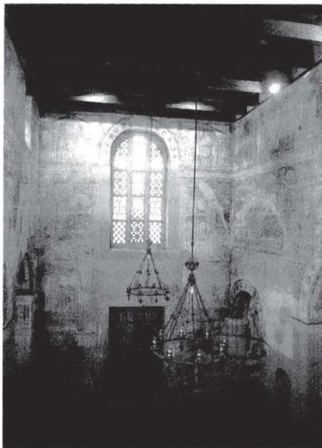
Figura 2.—Vista general de la Nave Transversal hacia el Sur.
