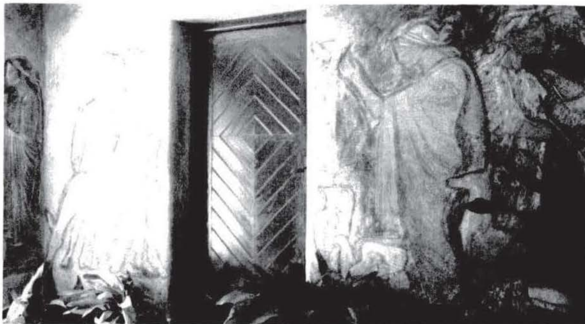
Figura 20. Pintura mural ejecutada a la cera-jabón por José Cuni en 1964. Estado actual. La técnica a la cera-jabón permite una sencilla ejecución de grandes superficies murales y tiene una magnífica conservación.
