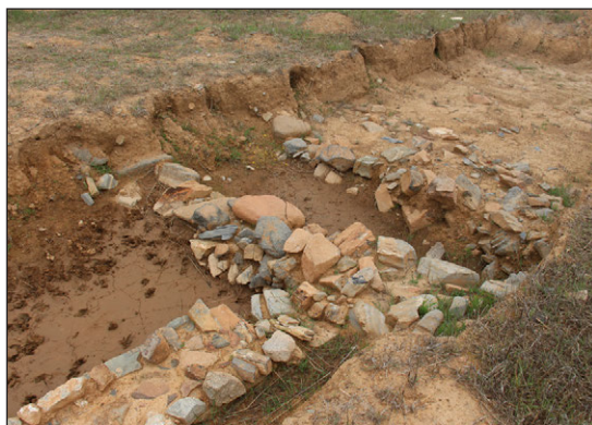
Figura 16. Detalle de la solución constructiva empleada en la realización del muro perimetral externo del anfiteatro, sondeo 4 (S4)
