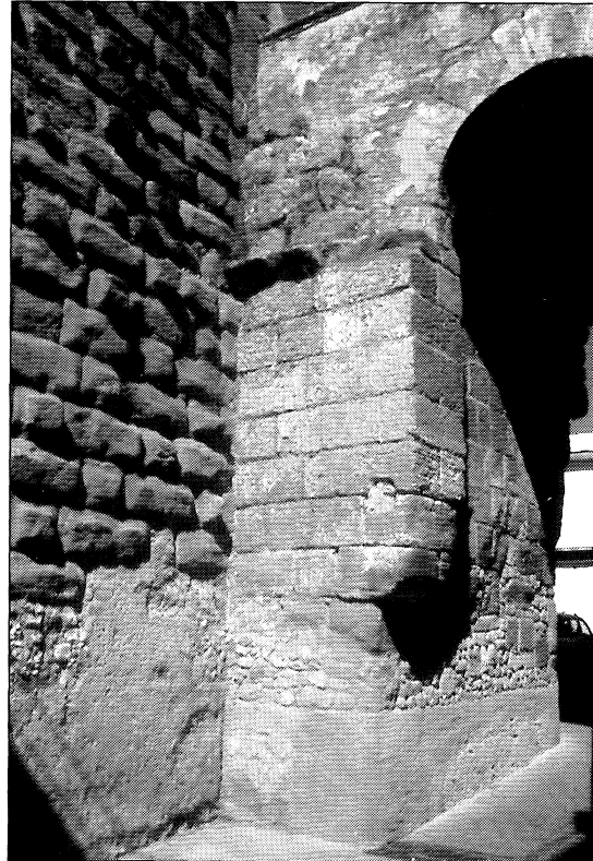
Fig. 8. Aspecto parcial de la Puerta de Sevilla, de Carmona, en el que se observa el adosamiento de las puertas abovedadas romanas al antiguo bastión púnico de sillares almohadados (fot. J. Blánquez).
